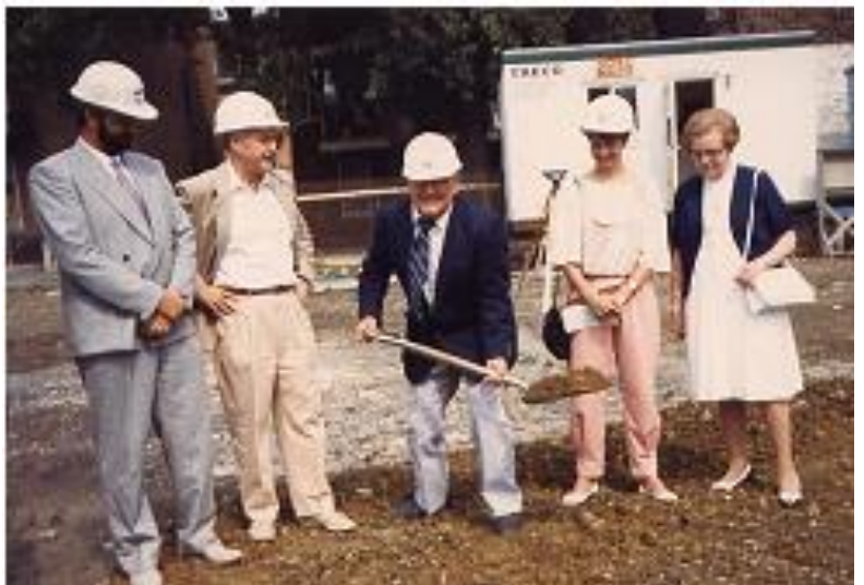
Construit sur une fondation solide : Benny Benoy et autres creusent le sol pour amorcer le centre d'hébergement en 1988
